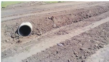
Дорожная служба ЛПХ приступила к укладке водопропускных труб по дороге от Карпогор до лесфонда «Лешуконское», что позволит обеспечить отвод воды. Искусственные сооружения будут проложены на участке протяженностью 150 км, для этих целей понадобится 44 трубы диаметром 60 см и 100 шт. — диаметром 90 см, всего порядка 150 штук. Завершить все работы необходимо к концу лета 2019 г.
