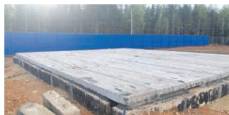
В Пинежском леспромхозе продолжается строительство столовой. На сегодня готов фундамент, смонтированы перекрытия из 36 плит. Следующим этапом станут работы по подводке инженерных сетей и возведению каркаса стен объекта. Напомним, что здание рассчитано на 70 мест, сейчас для сотрудников ЛПХ функционирует временно построенная столовая.
